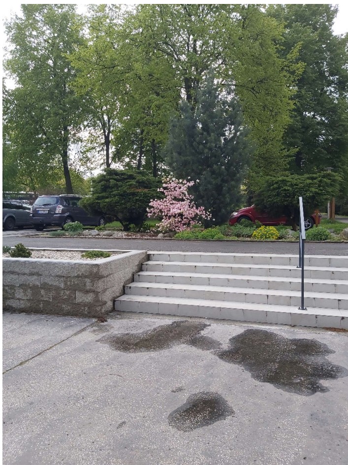
Oprava venkovního schodiště
